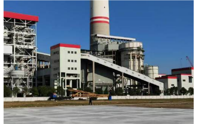
某电厂建筑外墙
