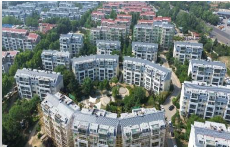
老旧小区瓦屋面防水改造项目
