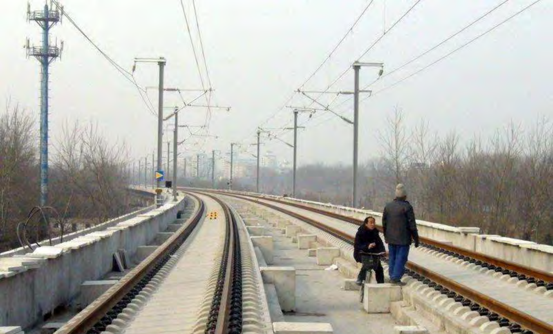
京津城际铁路 1,000,000平方米，2007年
