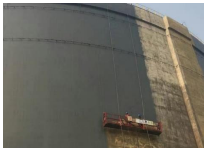
LNG储罐外防腐
