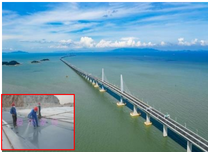
港珠澳大桥岛隧工程
