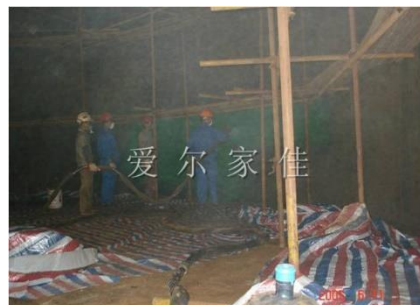
储罐内壁防腐
